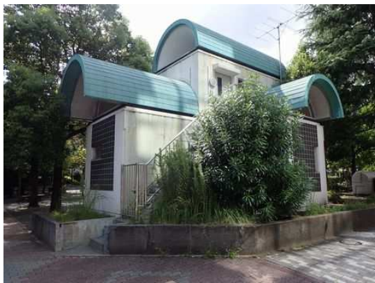
箱崎公園の公衆トイレ 2Fは防災倉庫として使用 工事期間中は使用できないので注意
