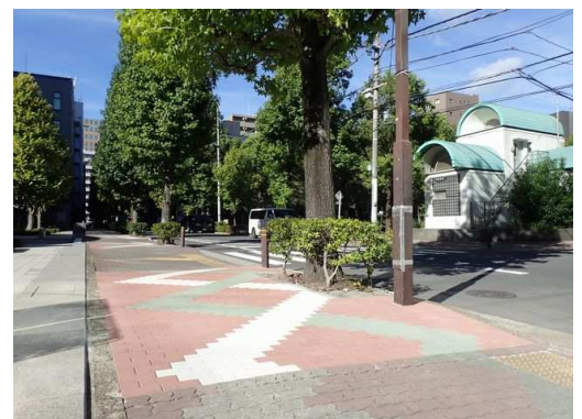
段差が解消された歩道
